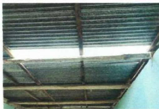
Foto 4: Sustitución e instalación de Láminas y estructura de madera por metal
