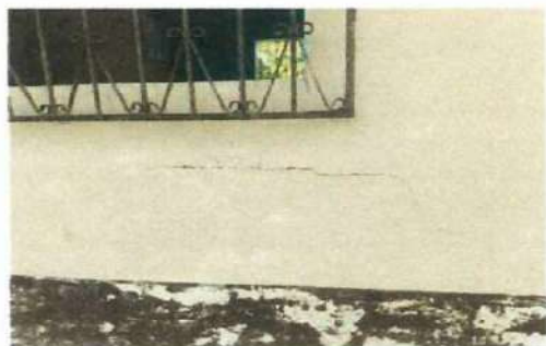
Foto 5: Cambio de Pintura
