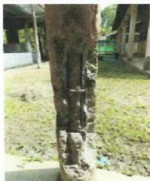
Foto 3: Cambio de parales de concreto por metal.
