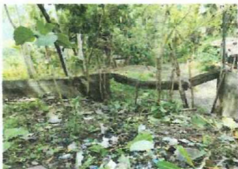
Foto 1: Reparación de Muro Perimetral de Block
